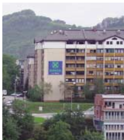
Lokacija RTP 110 / 10 (20) kV Koroška vrata
