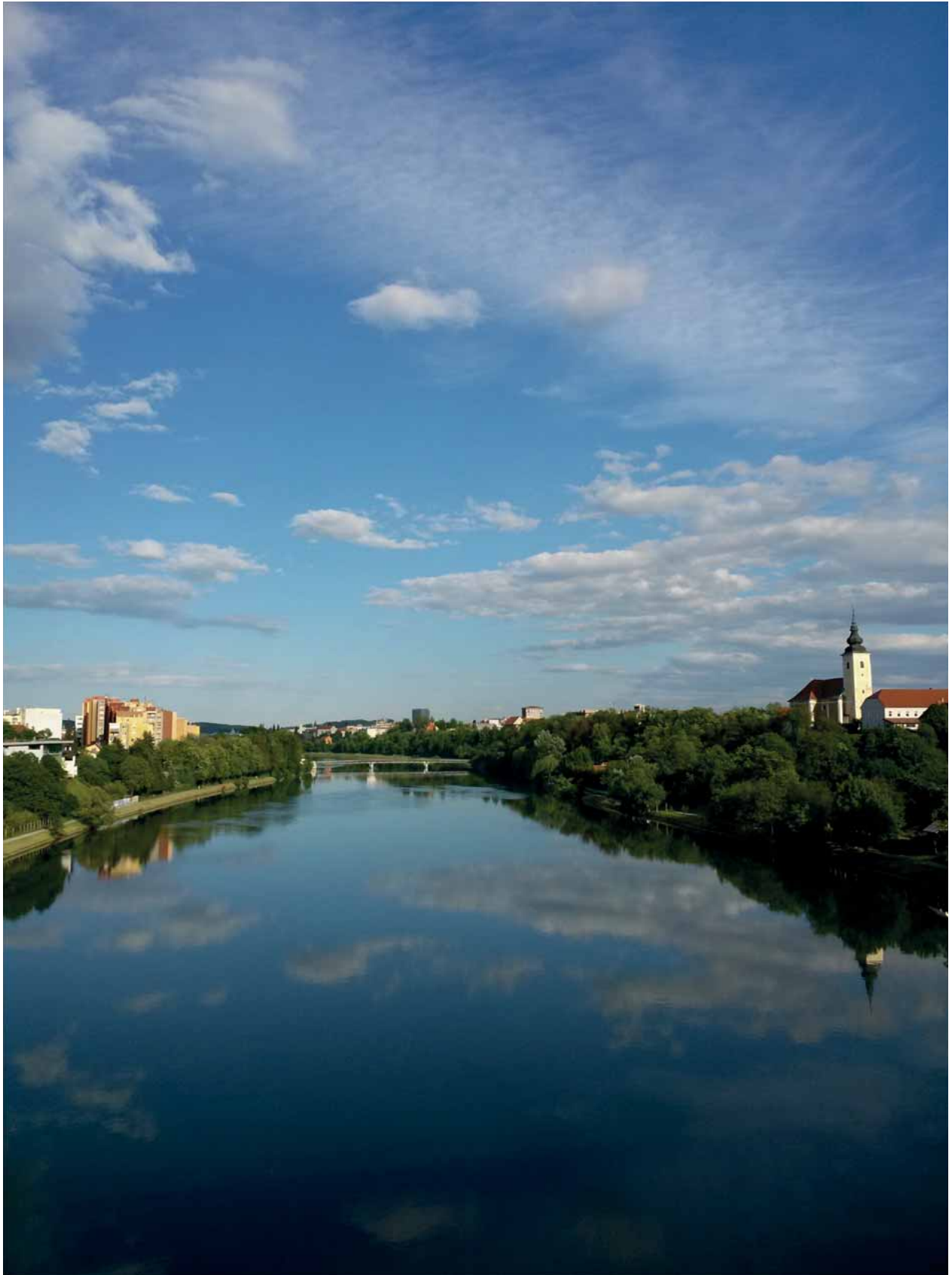
Fotografija 12: 110 kV kablovod med RTP Melje in RTP Koroška vrata je položen na rečno dno. Posnetek: mag. Boris Sovič, Elektro Maribor.
