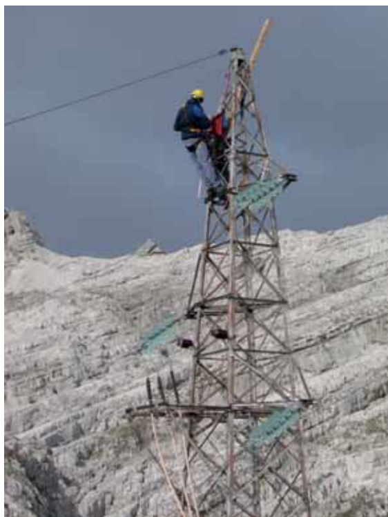
Slika 35: Obnova daljnovoda na Kanin. Posnetek: arhiv Elektro Primorska.
