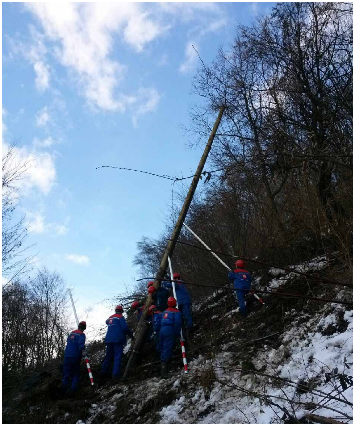
Fotografija 4: Postavljanje oporišča za poškodovan sredjenapetostni daljnovod na težko dostopnem območju Kamniške grabe. Posnetek: mag. Boris Sovič, Elektro Maribor.
