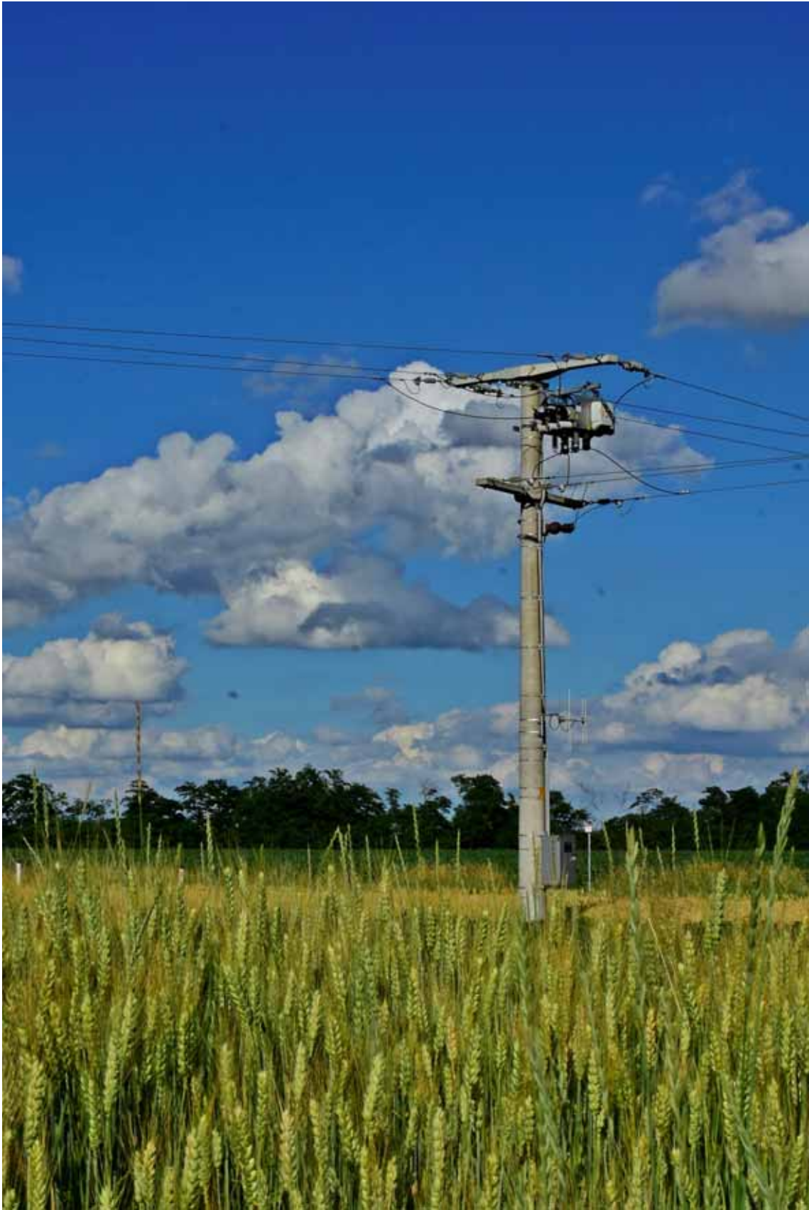
Fotografija 10: Srednjenapetostno omrežje v Prekmurju. Posnetek: Boštjan Rous, Elektro Maribor.
