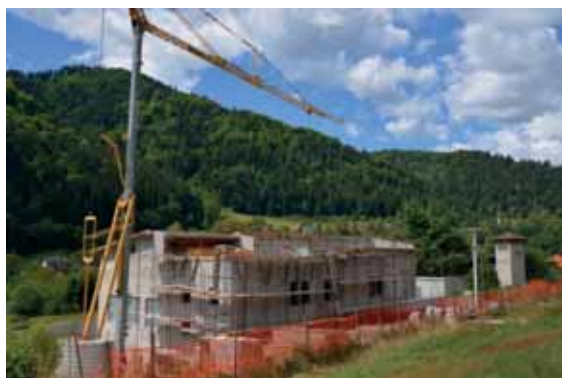
Slika 77: Razdelilno transformatorska postaja Podvelka med gradnjo. Posnetek: Aleš Damjanovič, Elektro Maribor.
