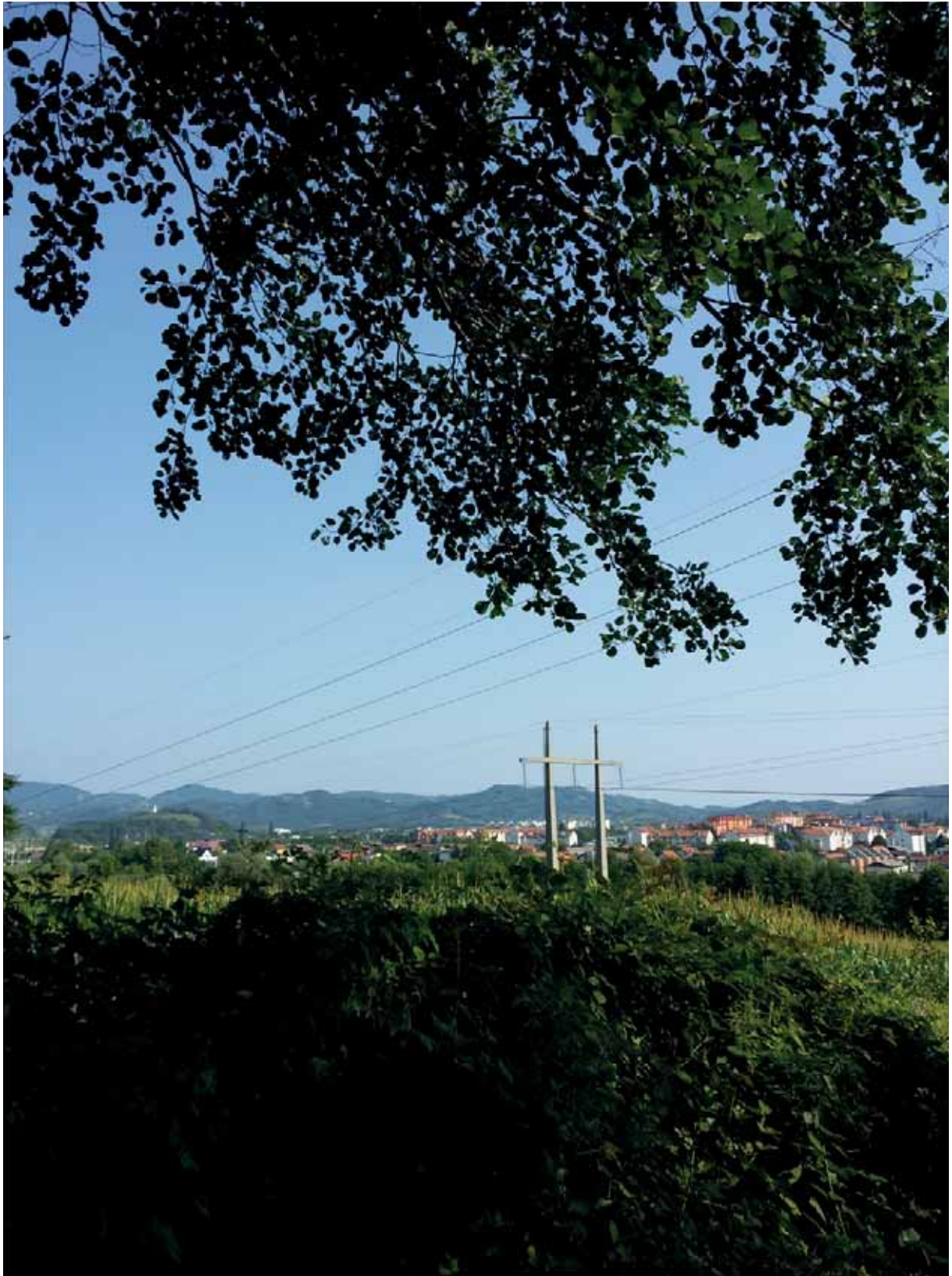
Fotografija 14: Visokonapetostni daljnovodi med RTP Pekre in RTP Maribor. Posnetek: mag. Boris Sovič, Elektro Maribor.
