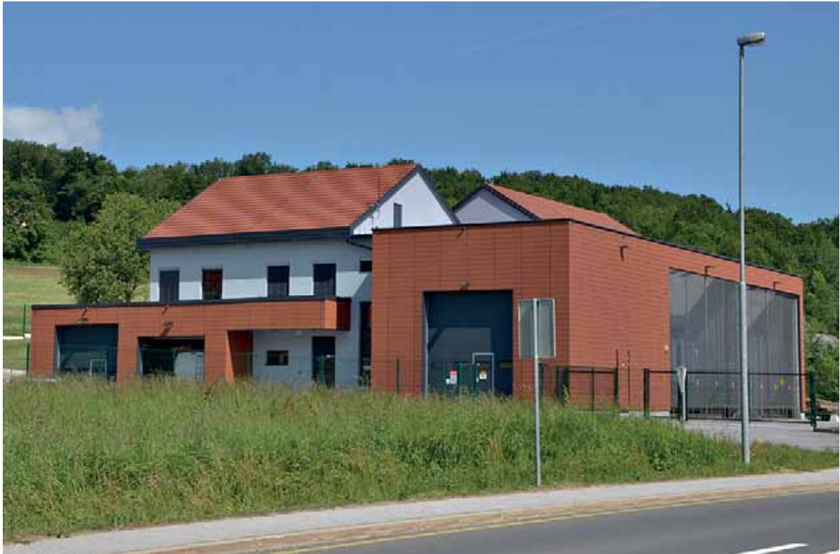
Fotografija 9: Notranjost in zunanost daljinsko vodene razdelilno transformatorske postaje Mačkovci. Posnetka: mag. Boris Sovič in Boštjan Rous, Elektro Maribor
