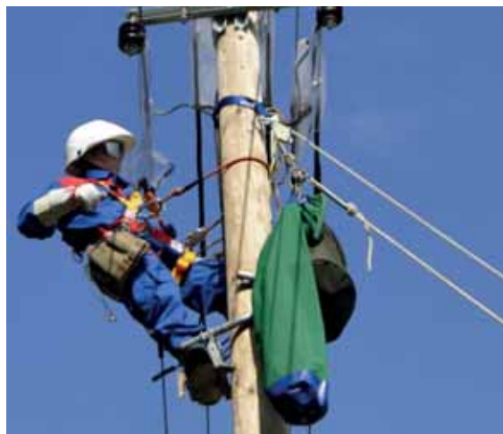
Slika 44: Delo pod napetostjo. Posnetek: arhiv Elektro Maribor.
