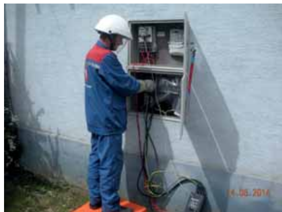
Slika 9: Vgradnja naprednih merilnih sistemov. Foto: arhiv Elektro Maribor.
