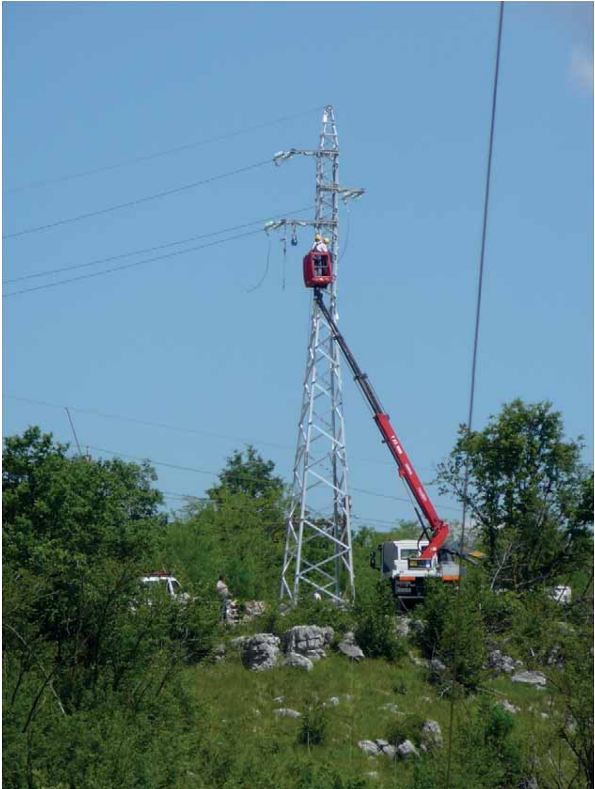
Fotografija 7: Gradnja elektrodistribucijskega omrežja. Posnetek: arhiv Elektro Primorska.
