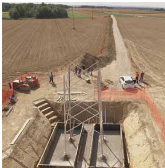
Slika 75: Gradnja visokonapetostnega daljnovoda na območju Goričkega. Posneto iz drona, arhiv Elektro Maribor.
