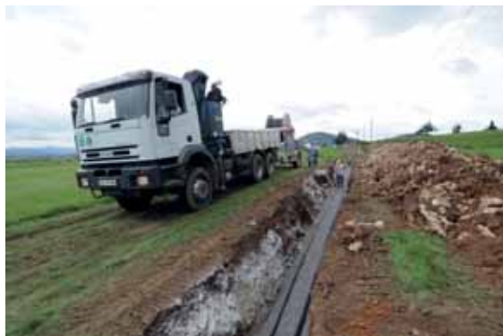
Slika 6: Gradnja kablovoda med Pivko in Selcami. Posnetek: arhiv Elektro Primorska.
