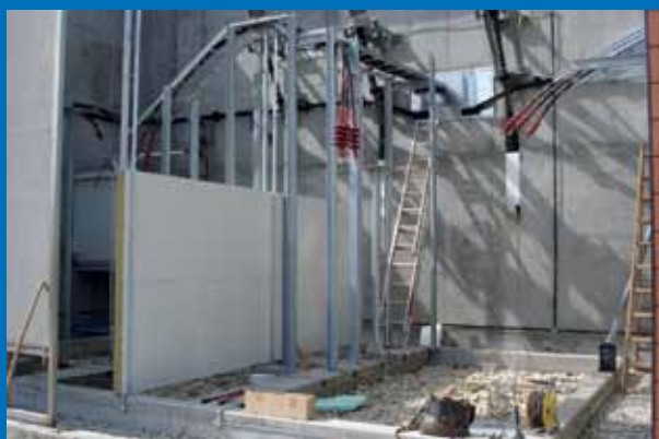
Priprava dveh trafo boksov za namestitev transformatorjev 35/20 kV
