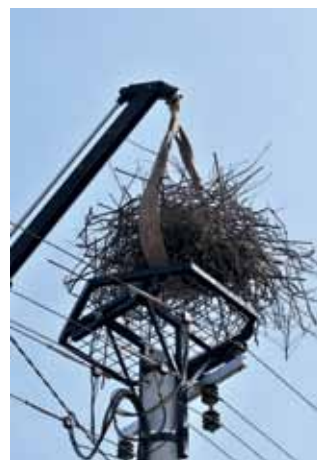
Selitev gnezda na betonski drog
