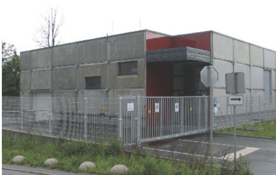
RTP Koroška vrata
