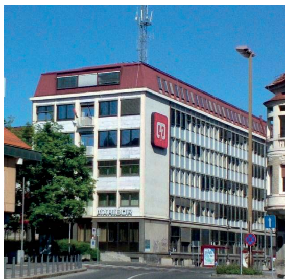
Slika 1: Sedež družbe Elektro Maribor d.d. na Vetrinjski ulici v Mariboru.
