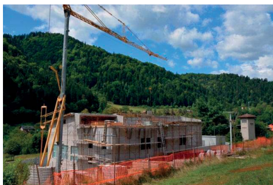
Slika 2: Gradnja razdelilne transformatorske postaje.
