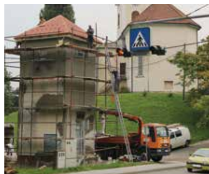
Obnova transformatorja Gornja Radgona
