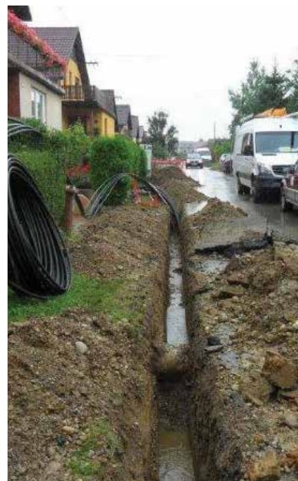
Priprava jarka za položitev kablovoda
