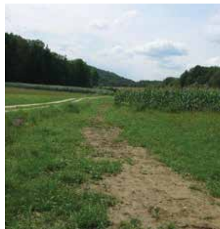
Pogled na del trase SN kablovoda
