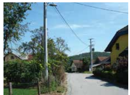
TP Lončarovci in NN omrežje po obnovi
