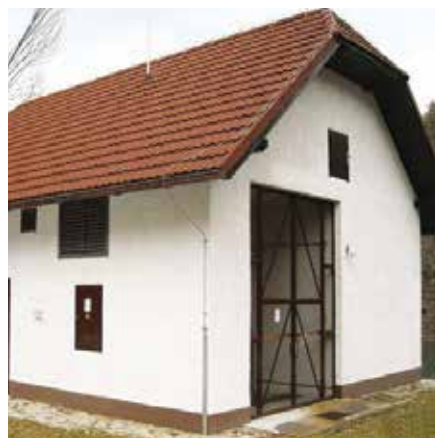
Mala hidroelektrarna Činžat I
