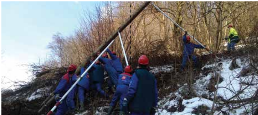
Postavljanje drogov na nedostopnem terenu v Kamniški grabi
