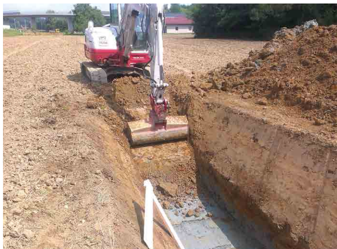
Priprava trase za kablovod
