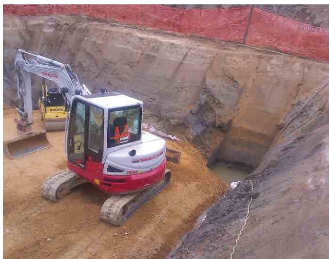
Izvedba sanacije temeljnih tal pred izvedbo temeljev daljnovoda
