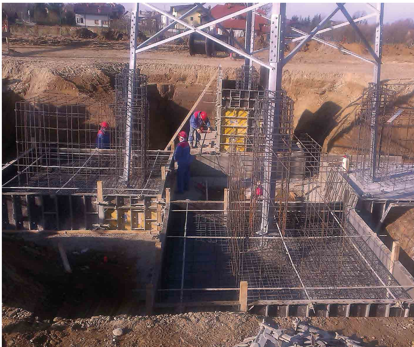
Opaževanje in vezanje armaturnega jekla za temelj daljnovoda
