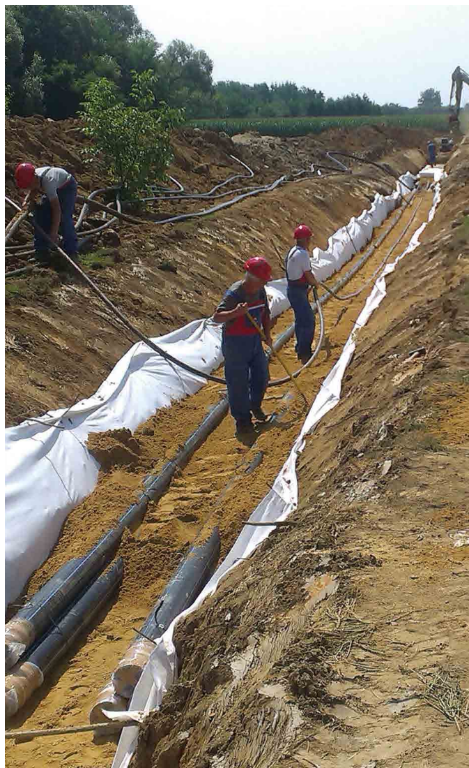
Sodelavci SE Ljutomer izvajajo cevno kanalizacijo za kablovod
