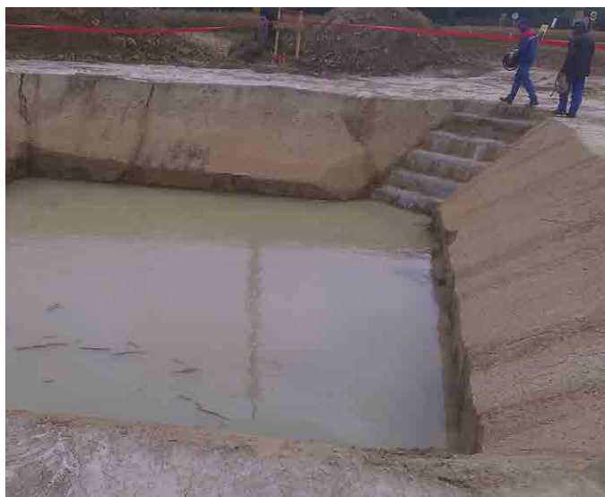
Po dežju je bilo potrebno zaradi visoke podtalnice črpati vodo
