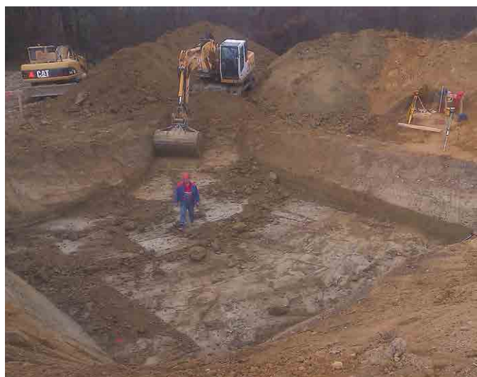
Pričetek izkopa gradbene jame-v izvajanju SE Ljutomer
