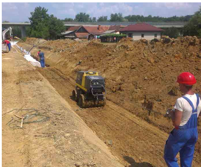
Zasip cevne kanalizacije kablovoda
