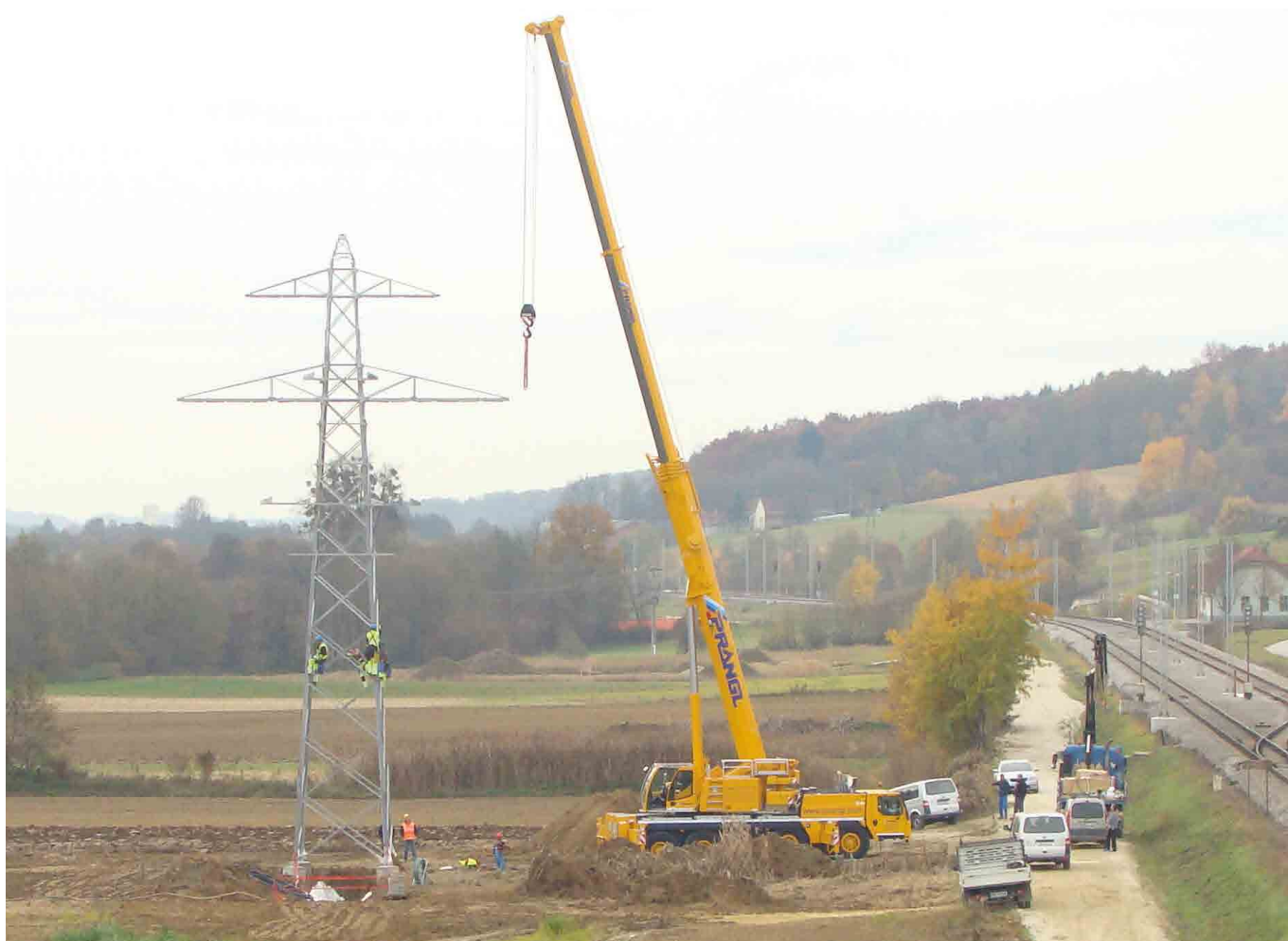
Postavljanje jeklene konstrukcije-konice
