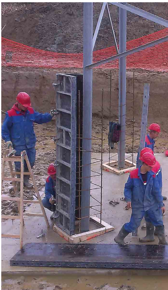
Betoniranje nožnih delov jeklene konstrukcije na SM 63 (zadnje stojno mesto), na predhodno že izvedeni temeljni plošči (količina vgrajenega betona znaša 46 m 3 )
