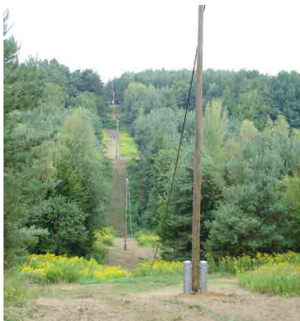
Obnova daljnovoda Trdkova
