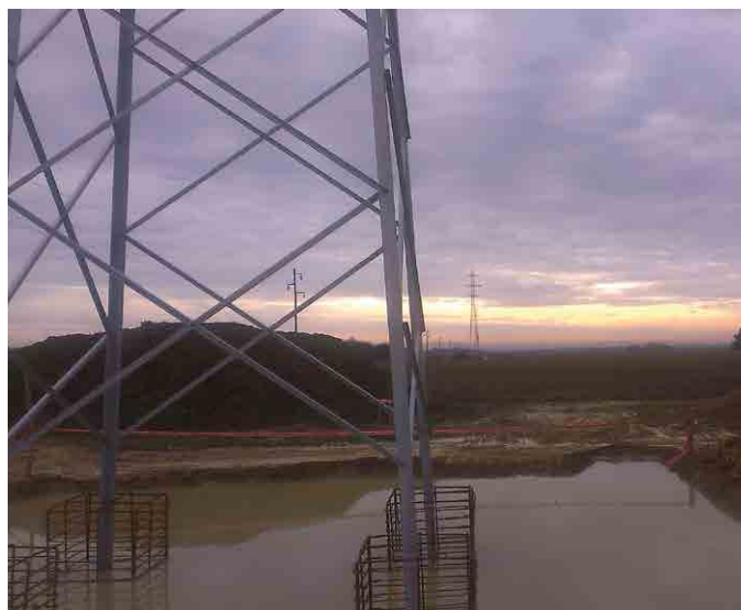
Vsakodnevne razmere na gradbišču v Prekmurju
