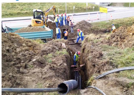
Gradnja kablovoda Recek
