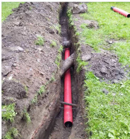
Izgradnja kablovoda TP Elrad in TP Vrtna
