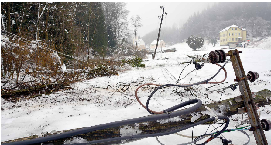
Sanirati je bilo potrebno številne podrtе droge in pretrgane vodnike
