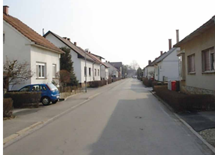
Obnova nizkonapetostnega omrežja
