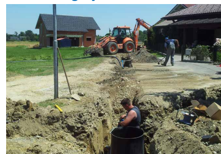
Izgradnja kablovoda Radenci Finžgarjeva ulica
