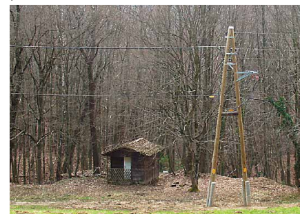
DV Podlože 3–Piške: zamenjani so poškodovani drogevi, vodniki so zamenjani z univerzalnim kablom
