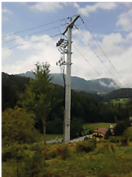
Obnova razdelilno transformatorske postaje 110/20 kV Slovenska Bistrica
