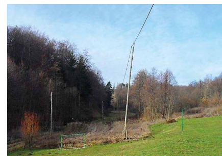
DV Grajena v Globoki grabi: vodniki so zamenjani z univerzalnim kablom
