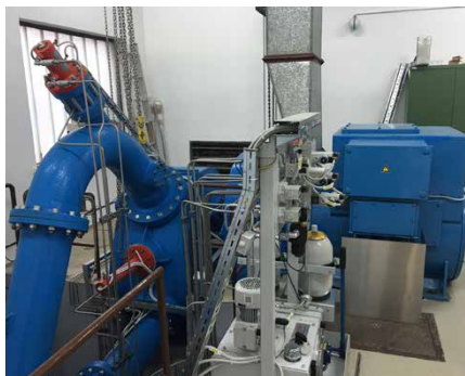
Strojna hidravlična oprema z generatorjem na Činžatu I
