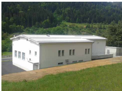
Nová rozdelilná transformátorská postaja RTP Podvelka
