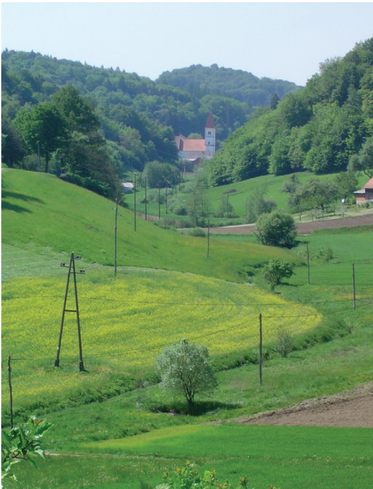
Slika 21: Srednjenapetostno nadzemno omrežje na območju Gradu na Goričkem. Foto: Boštjan Rous.
