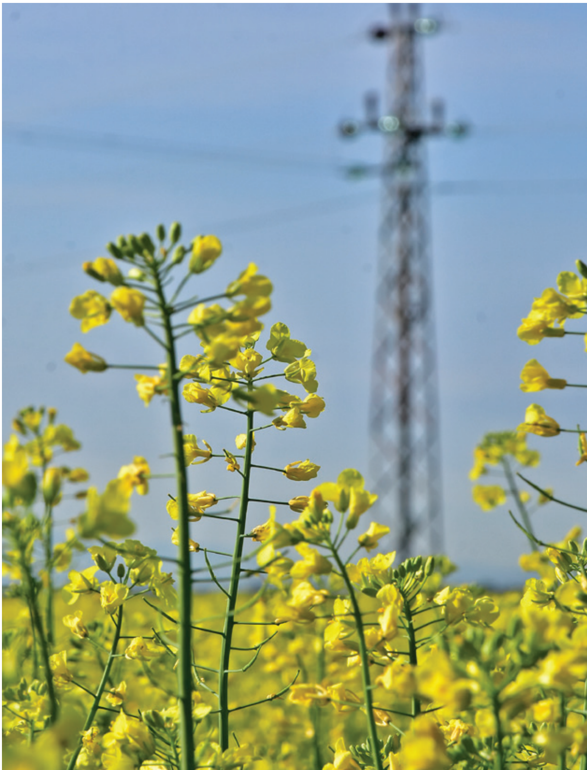
Slika 29: Srednjenapetostno omrežje na območju Puconcev v Prekmurju. Foto: Boštjan Rous.
