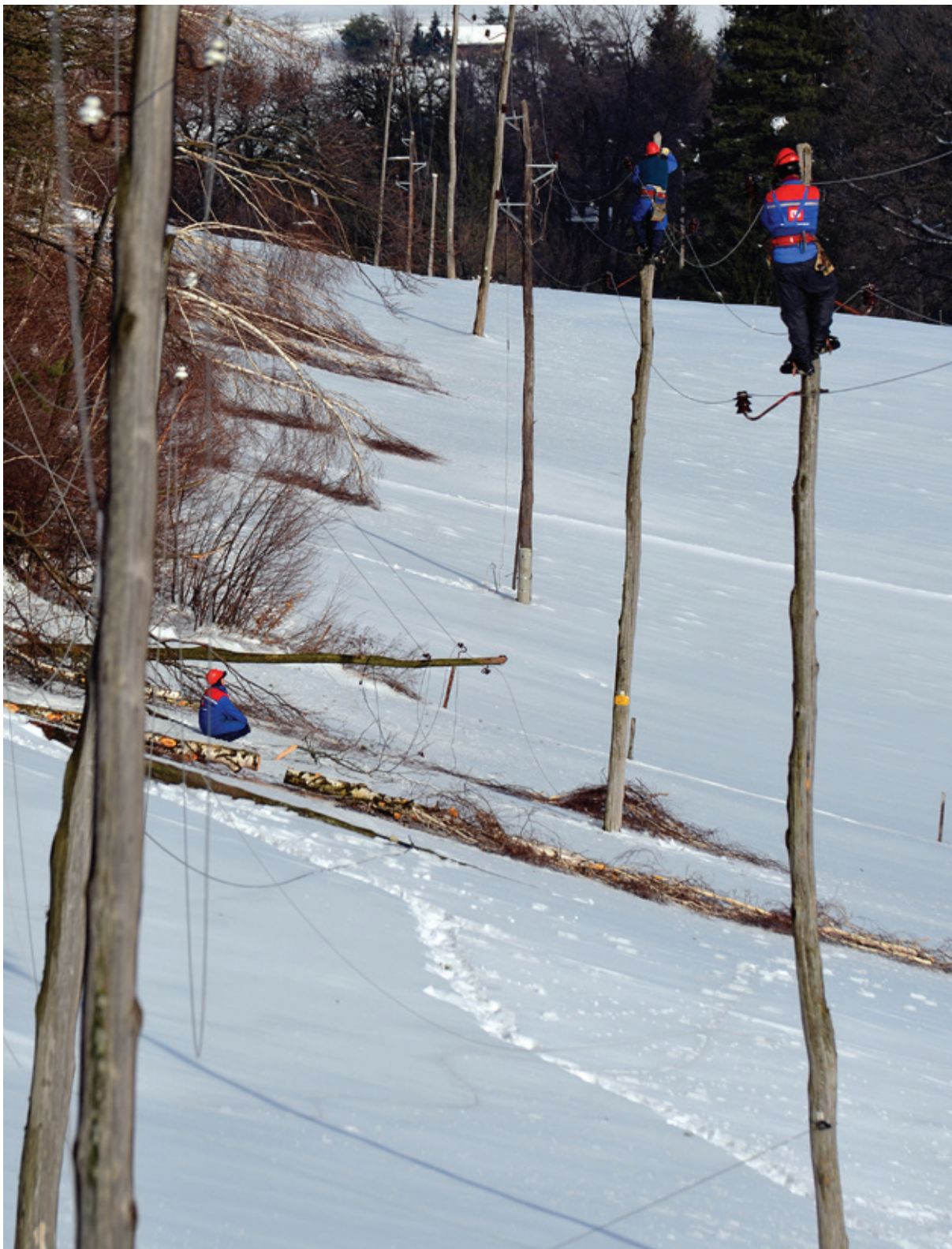
Slika 44: Obnavljanje omrežja na območju Ošlja na Pohorju po katastrofalnem žledu februarja 2014. Foto: Uroš Lednik.
