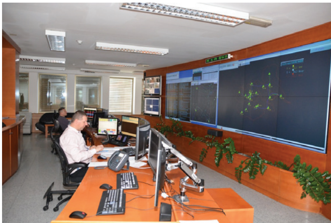
Slika 11: Distribucijski center vodenja Elektra Maribor. Foto: Aleš Damjanović.
