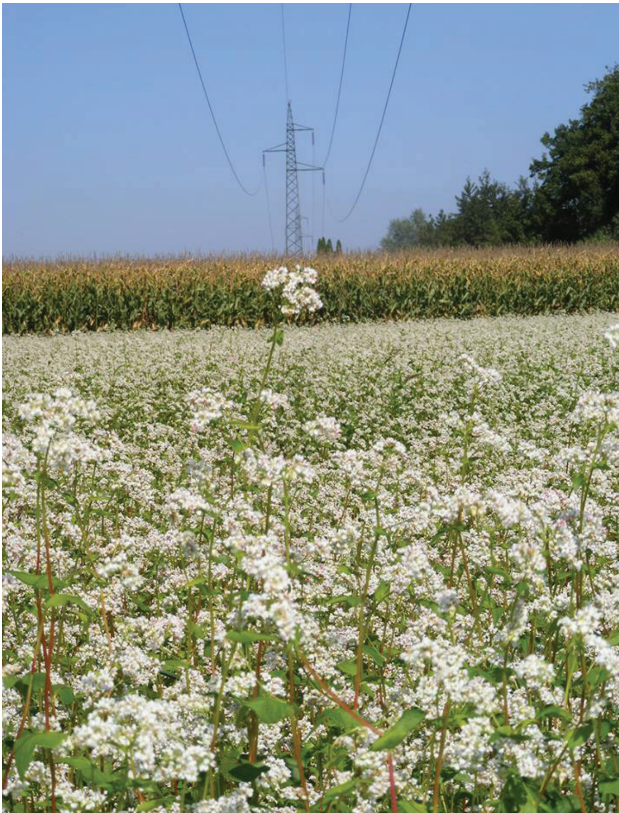
Slika 114: Visokonapetostni daljnovod na območju Križevcev pri Ljutomeru. Foto: Zdenka Veršič.
