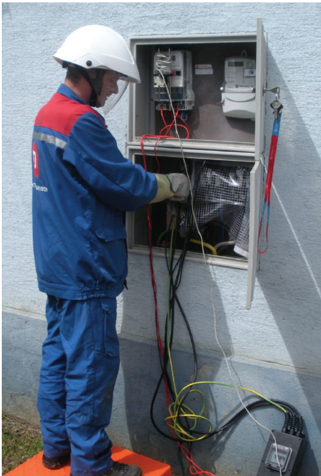
Slika 86: Zamenjava merilnih naprav. Foto: arhiv Elektra Maribor.
