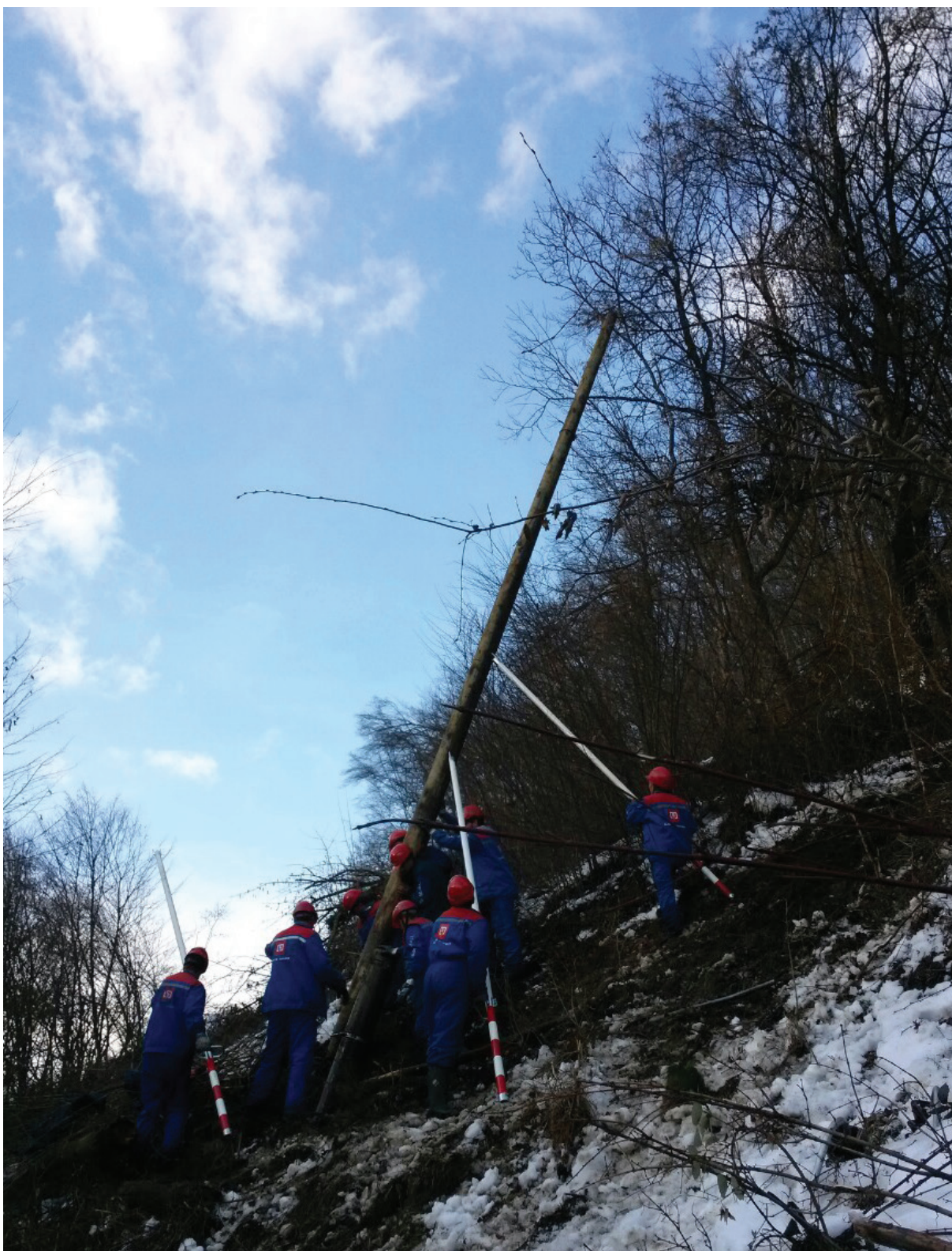
Slika 34: Postavljanje oporišča za srednjenapetostni daljnovod na težko dostopnem terenu v Kamniški grabi februarja 2014.
