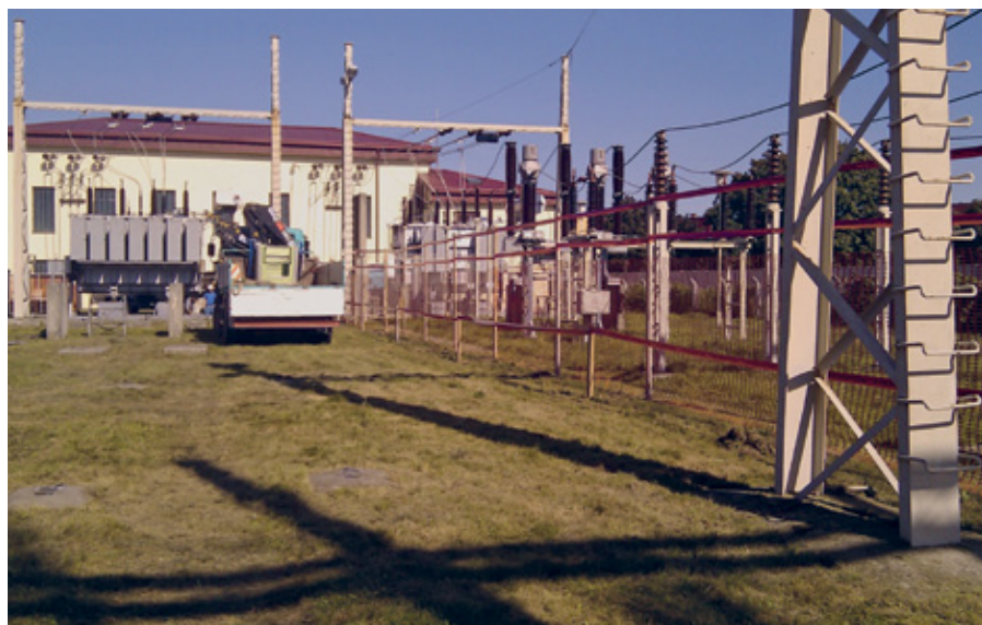
RTP Radvanje – prenova stikališča; priprava polovice stikališča na prenovu in varnostna zaščita preostalega stikališča v obratovanju
