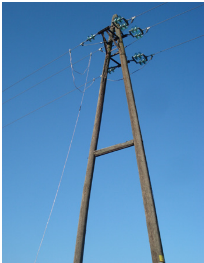
Izvedba ozemljitve na DV 20kV
