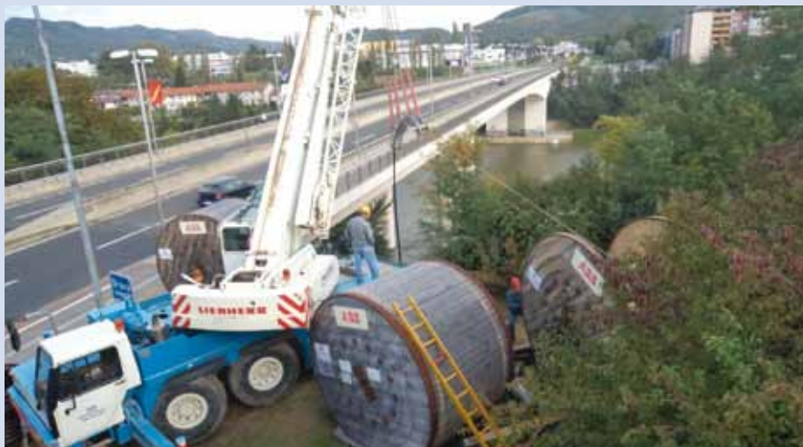
Polaganje 110 kV kablovoda med RTP Koroška vrata in RTP Pekre
