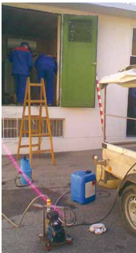
Sveža ideja Boštjana Behin - priprava za pranje transformatorja
