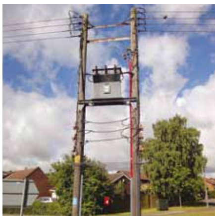
Zanimiva izvedba TP (slika 2)
