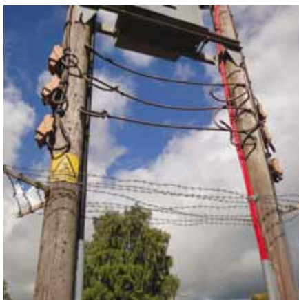
Izvedba zaščite z bodečo žico (slika 3)
