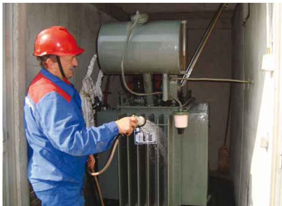
Sodelavec Boris Goričan pri pranju transformatorja z novo napravo
