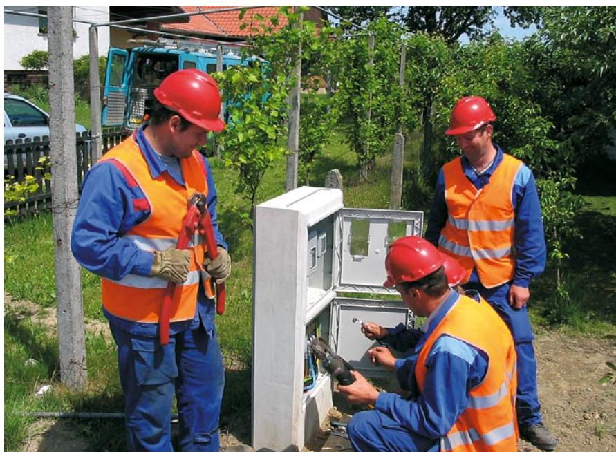
Boštjan Bratinščak, Franc Tigeli, Miran Štebih in Bojan Veršič na delovišču v Petanjcih.
