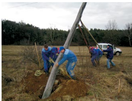
Ročno postavljanje nosilnega droga DV
