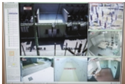
Opazovana območja kamer na objektu iz nadzornega centra
