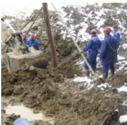
Zaposleni na SE Elektro Gradnje Ljutomer pri odpravi okvar.
