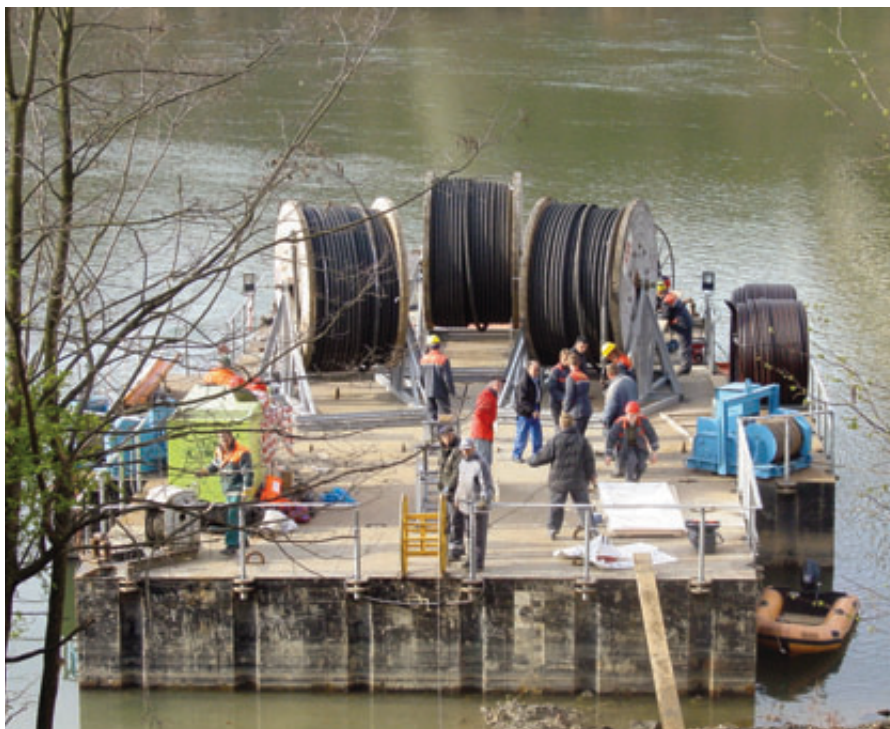
Začetek polaganja pontona
