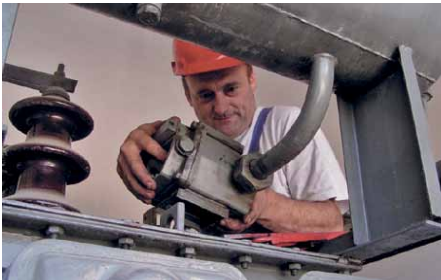
Boris Goričan pri izvedbi tesnenja energetskega transformatorja
