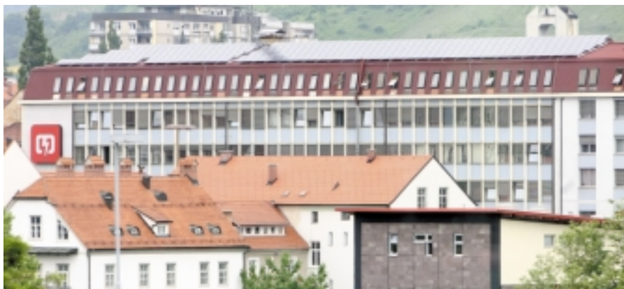
Sončni moduli elektrarne prekrivajo skoraj celotno površino južnega dela strehe, zato je MFE vidna predvsem z desnega brega Drave.
