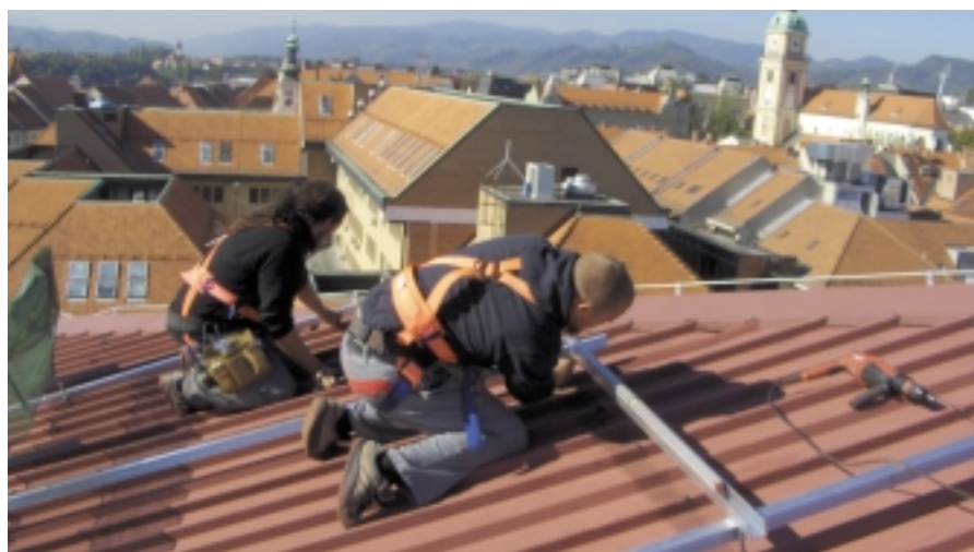
Zahtevna gradnja sončne elektrarne na strehi poslovne stavbe Elektra Maribor.
