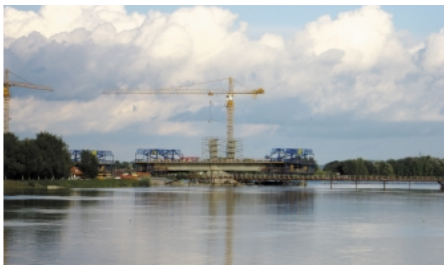
Gradnja Puhovega mostu.
