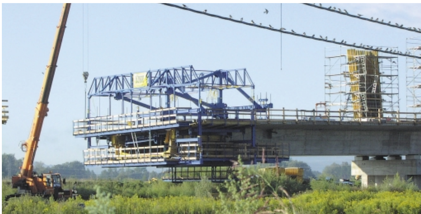
Potek gradnje mostu.
