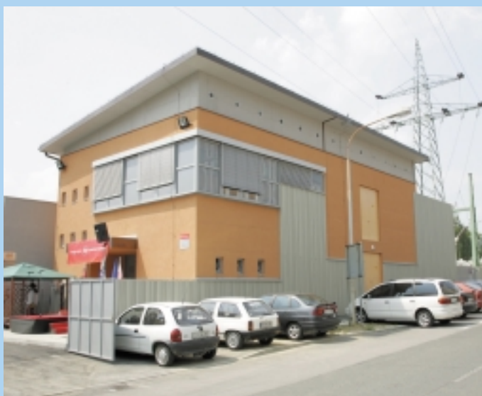
Nova stavba RTP Melje.
