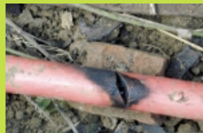
Prerezan 20kV kablovod.
