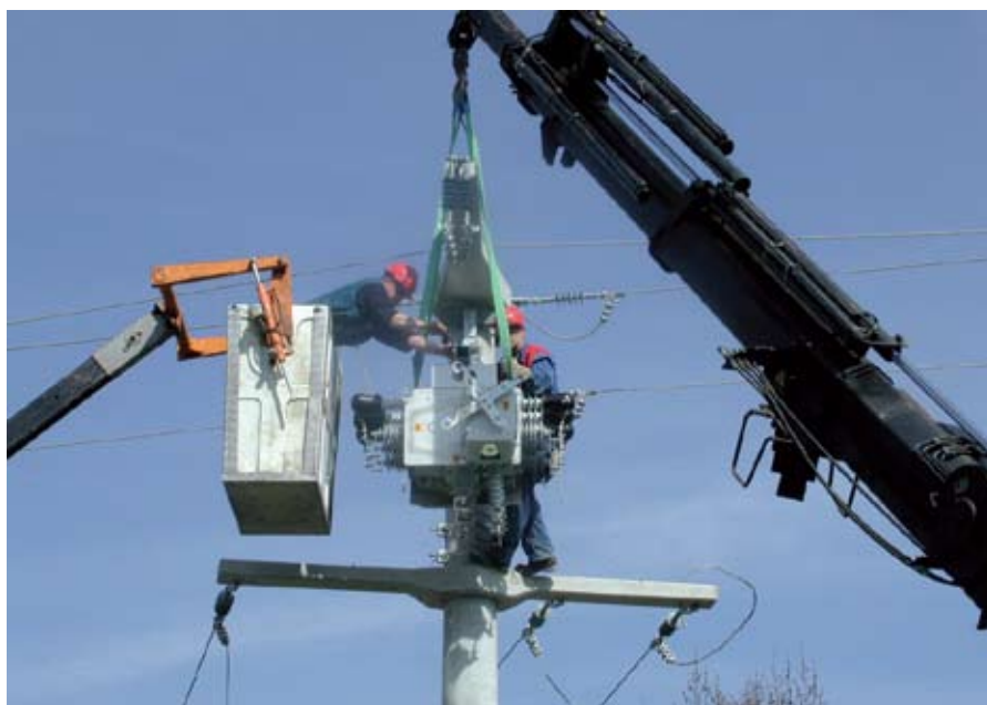
Popravlilo na daljnovodu
