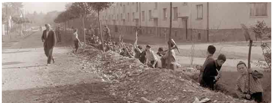
Pionirji med kopanjem kablskega kanala na Cesti zmage.
