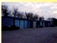
Izgradnja skladiščnih prostorov in garaž na lokaciji R. Pušenjaka 5
