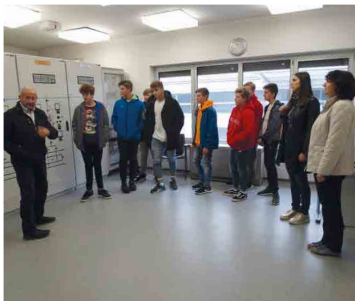
Vodja obratovanja Zvonko Črešnik je dijakom predstavil prenos in transformacijo energije do uporabnikov
