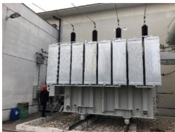
Slika 77: Novi energetski transformator v RTP Rače
