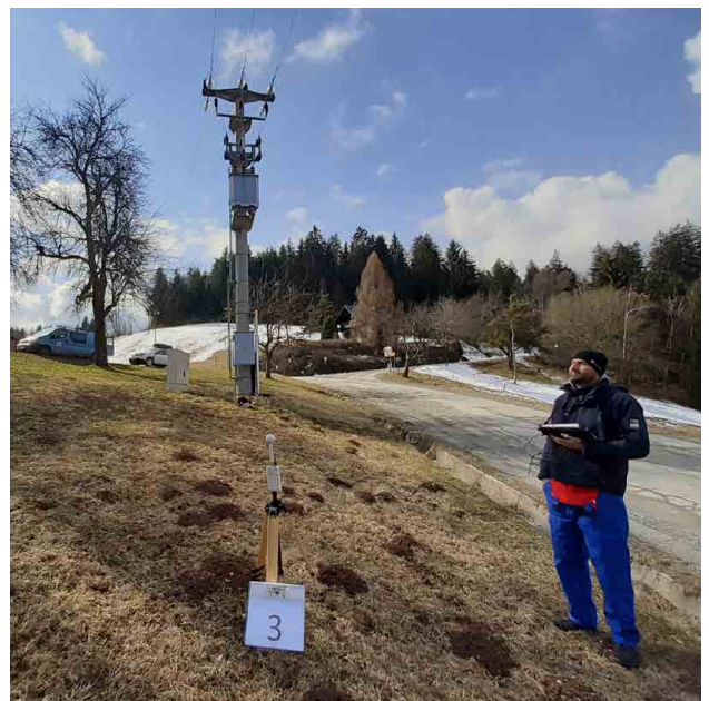
Sodelavec Bogdan Fluher pri izvajanju meritev.
