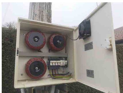
Lokacija montaže in izgled naprave.
