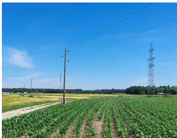
Postavitev novega betonskega droga na mestu prehoda iz nadzemnega v podzemni sredjenapetostni vod.
