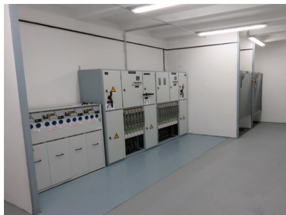
Slika 57: TP Moša Pijade, Maribor po rekonstrukciji
