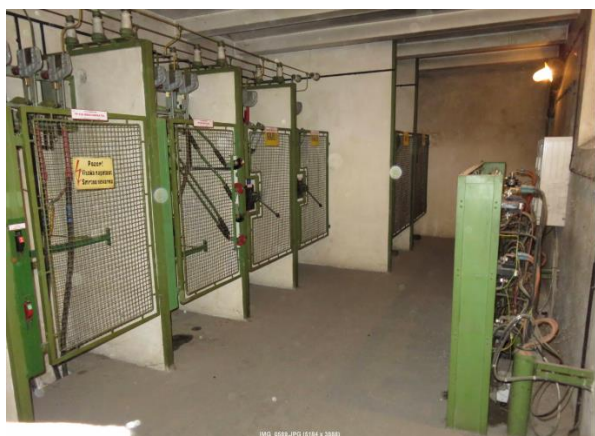
Slika 56: TP Moša Pijade, Maribor pred rekonstrukcijo
