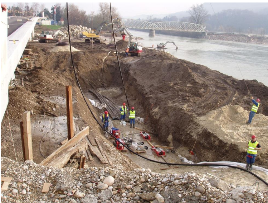
Slika 62: Izvajanje del na 110 kV KBV za potrebe HE na spodnji Savi
